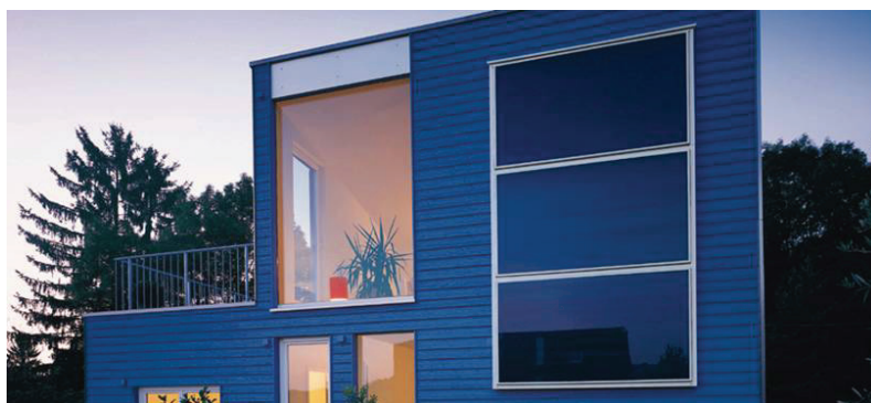
Schüco's solfangere montert vertikalt på en yttervegg.
