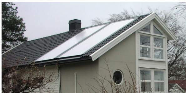
Solfangere fra Norsk Solfangerproduksjon montert på taket av en enebolig.
