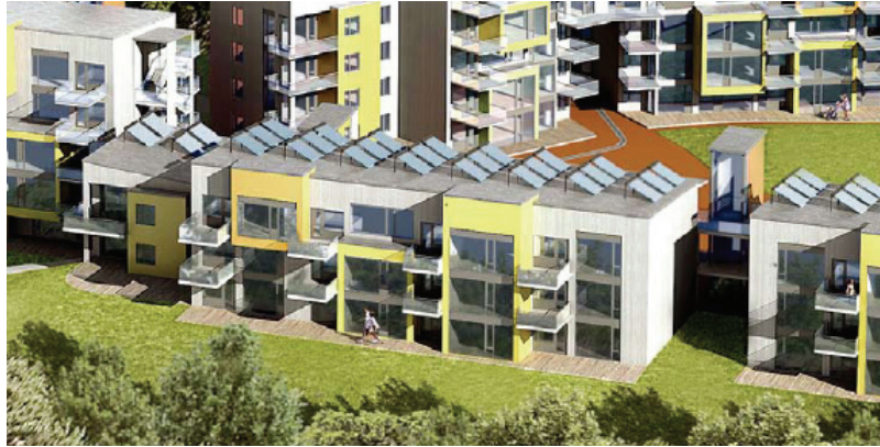
Figur 22. Boligblokker med passivhus-standard og solfangere på taket i Løvåshagen, Bergen. Illustrasjon: ABO-arkitekter.
