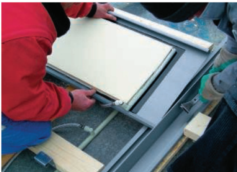
Montering av Quick-Step solpaneler.
